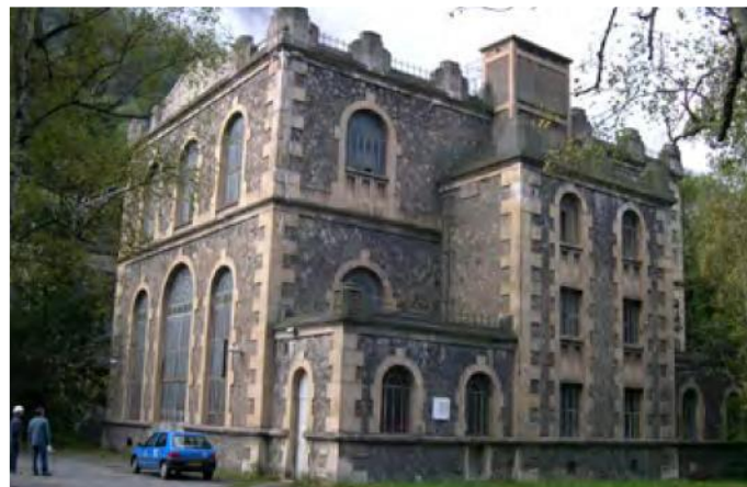
Figure 17 : Centrale des Vernes - Source : étude paysagère 2013
