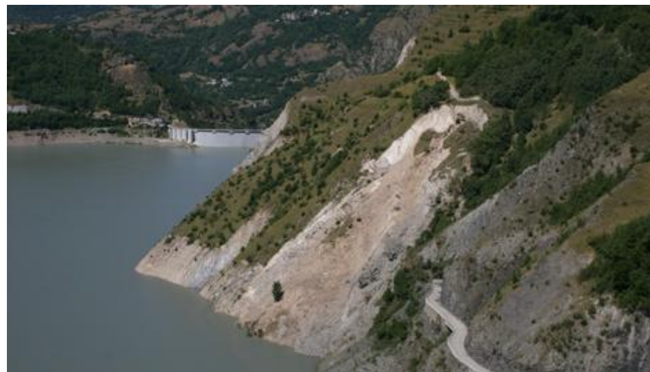
Figure 56 : Glissement de terrain au niveau du tunnel du Grand Chambon - Source Département de l'Isère
