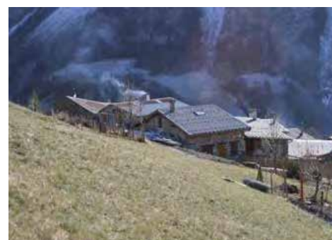
Ancrage des pignons Nord dans le versant
