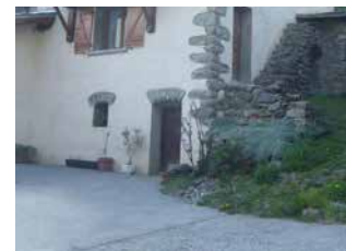
Originellement les enduits sont à la chaux (le mur respire, aspect moins uniforme et plus lisse) appliqués en couche fine. Les pierres d'angles tout comme les linteaux ne sont pas destinés à être vus. Ici, le résultat est grossier et tente de rappeler un aspect rustique qui n'a jamais existé.
