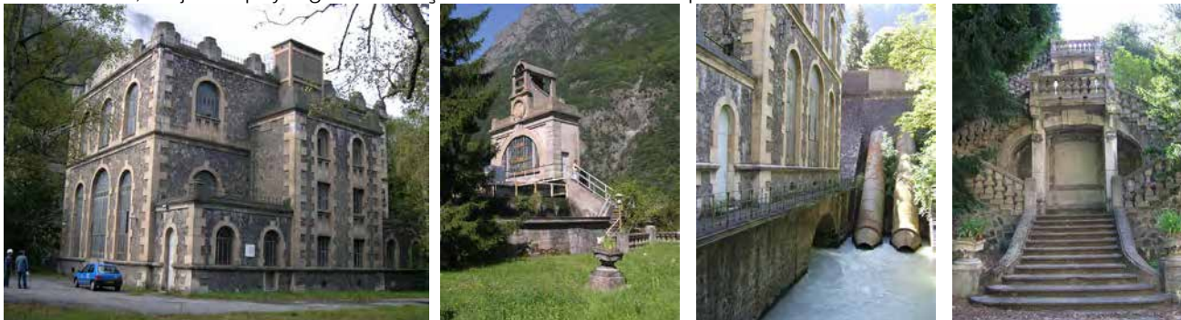
Centrale des Vernes. Sources : http://www.isere-patrimoine.fr
