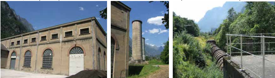
Centrale des Clavaux. Sources : http://www.isere-patrimoine.fr
