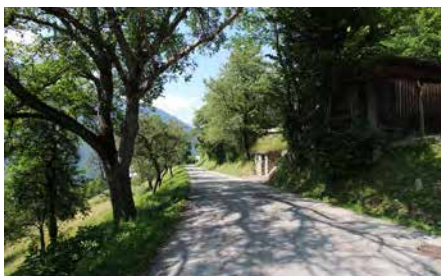
Des routes en balcon qui s'insèrent dans la pente (échelle humaine, faible emprise, abords enherbés et faible présence d'éléments routiers standardisés) et offrent des vues remarquables lorsque les pentes sont encore exploitées.
