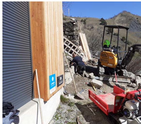
Création d'un mur de soutènement
