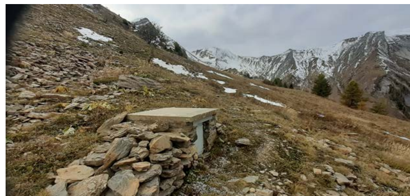
Entretien captage Villard Reymond
