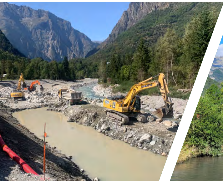
Bourg d'Arud - Travaux d'urgence 2024
