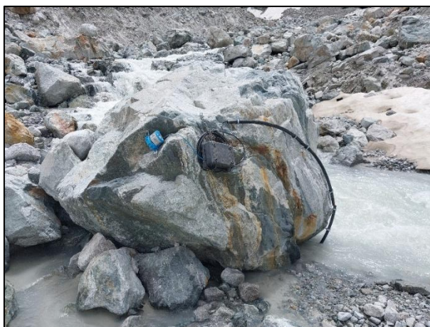
Figure 7 : Photo de la chaîne de mesure lors de l'installation
